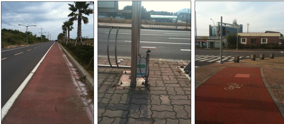
<그림 V-3> 자전거 도로 설치 현황 및 관련 시설
