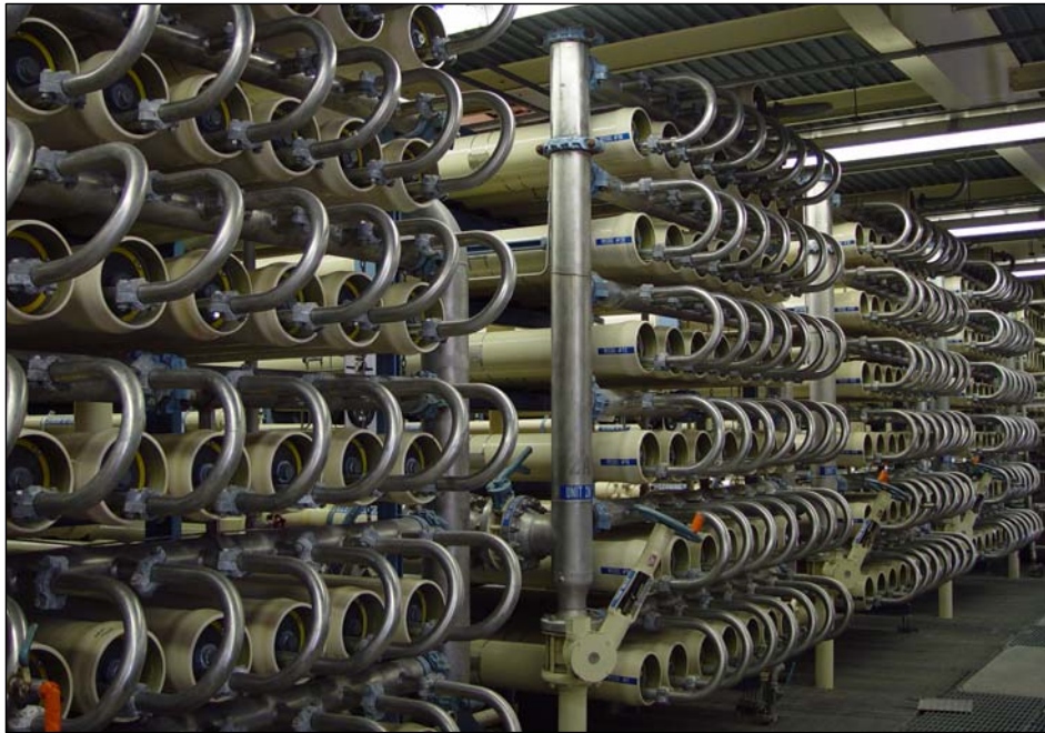
<사진 10> OR 생산을 위한 역삼투막 설비의 모습
