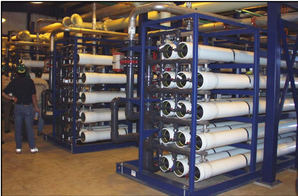
<사진 5> RO수 생산을 위한 역삼투막 설비의 모습
