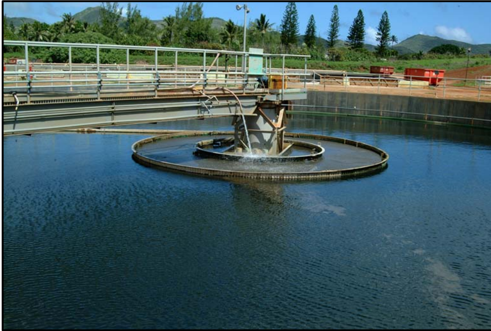
<사진 8> 최종 침전조에서 염소소독을 하고 있는 모습
