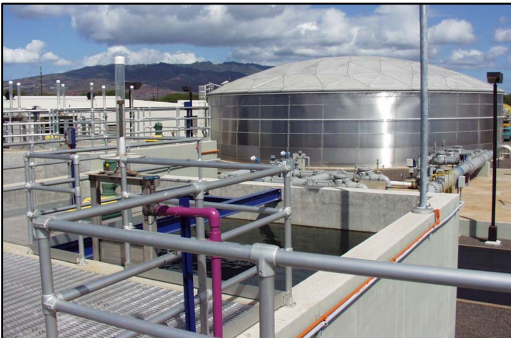
<사진 3> RO공정으로 보내는 처리수 탱크와 모래여과지의 모습
