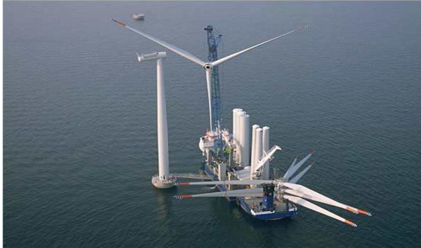
(그림 2-9) 덴마크 Nysted 해상풍력발전단지 건설
