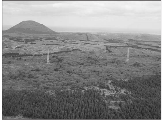
<사진 12> 세화곶자왈에 설치된 송전탑
