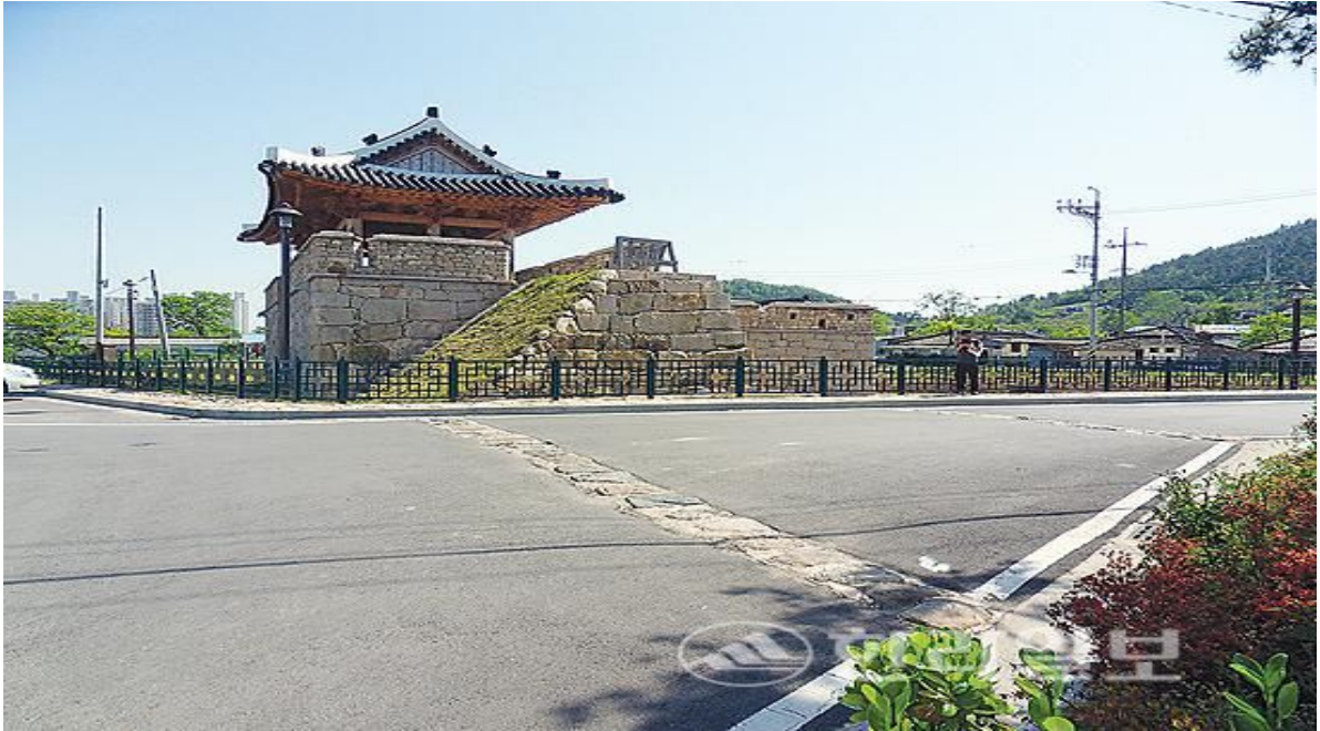
사진 위부터 면천읍성 남문복원 공사를 위한 발굴현장, 안산읍성의 복원된 관아지, 나주성 성문이다. 나주성 성문의 경우 성곽이 허물어진 곳은 바닥에 성곽 표시를 해놓고 있다.
