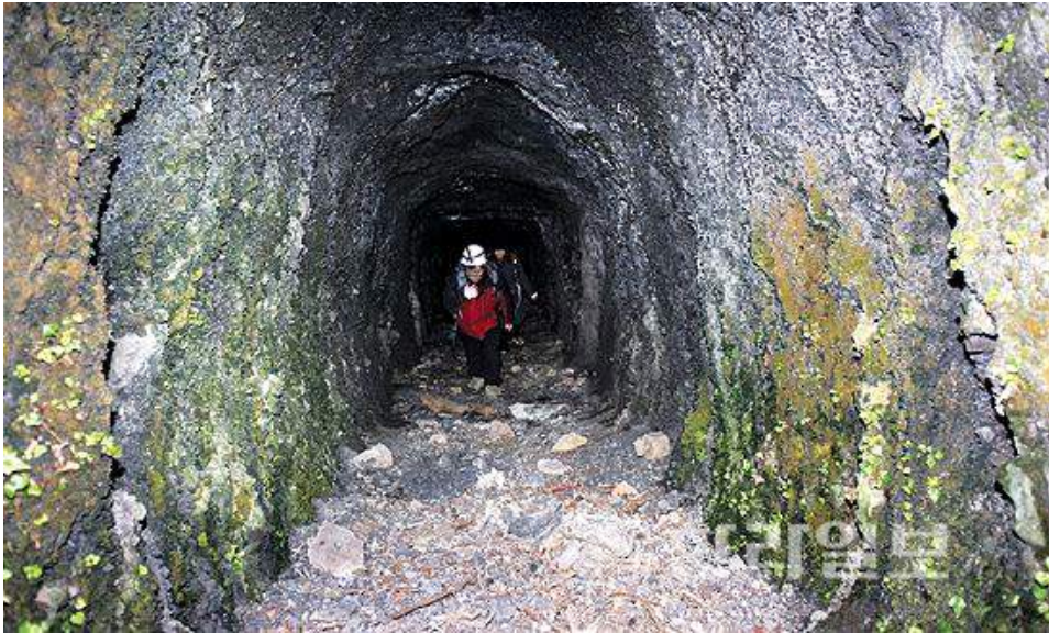
▲사라봉에 구축된 일본군 대형갱도의 출입구 부분.
