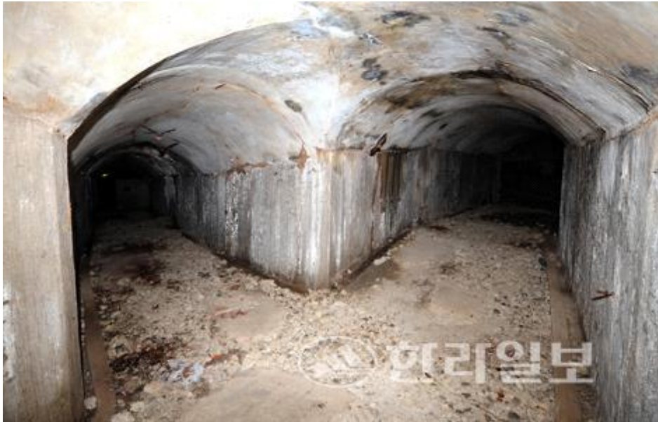
▲고치현 낭고쿠시에 있는 진야마지하송신소호 내부. 산의 지하를 뚫고 콘크리트로 마감했다. /사진=이승철기자
