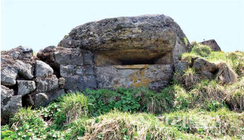
▲어승생악 정상부에 위치한 토치카 시설
