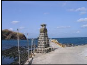
사진 44. 해안마을-한경면 고산리 자구내포구 도대불
