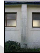
Fig. 22. 용수공소 버팀벽 (정면)
