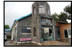
Fig. 7. (구)중문공소 (출입구 정면 부분 증축)
