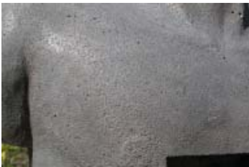
도24 광내기작업 후 쇠솔작업
