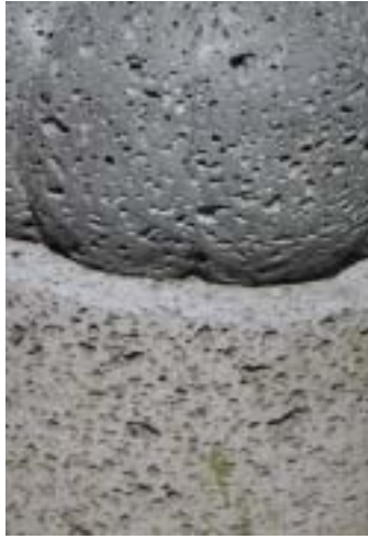
도22 그라인딩 후 쇠솔작업
