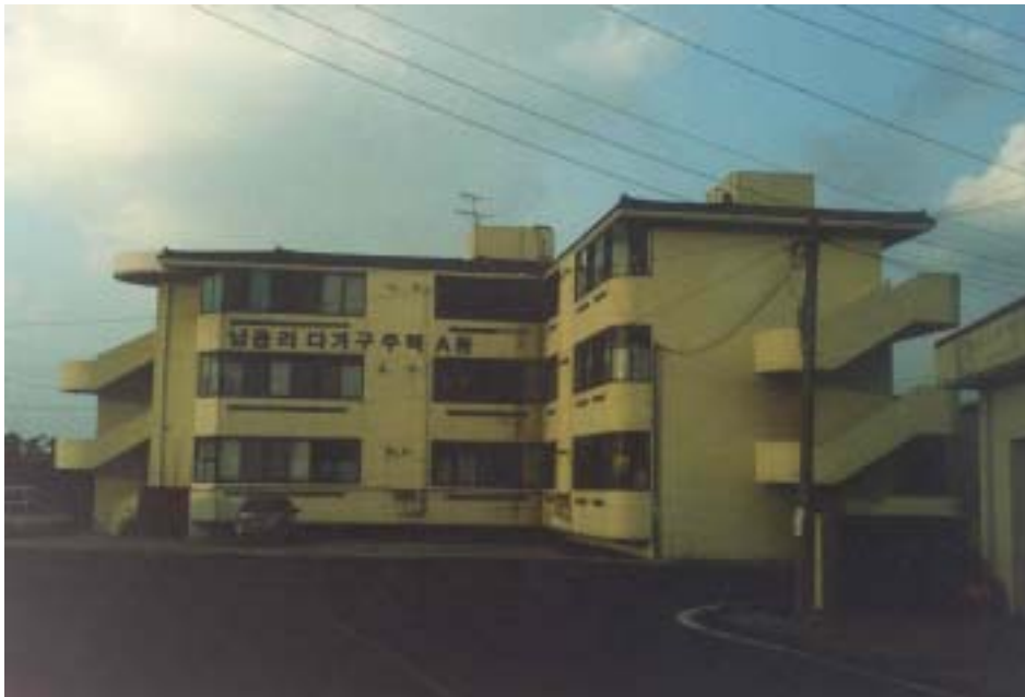
<사진 6> 학교살리기 사업으로 지어진 다가구 공동주택(2003. 3. 22. 연구자 촬영)
