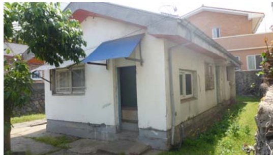
사진28. 현존 공영주택 후면
