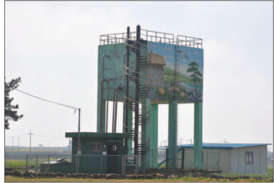
<사진 9> 마실땅케지구(D) 관정과 고가배수지(고산1리)
