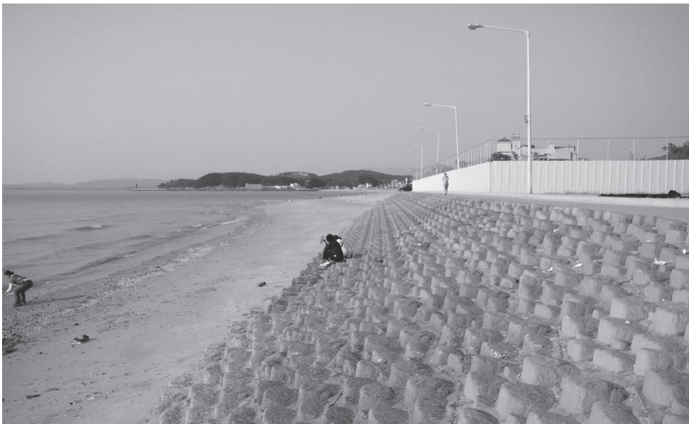
〈그림 2〉 연안정비사업을 통한 연안방재 사례 (호안)(충남 보령 무창포)
