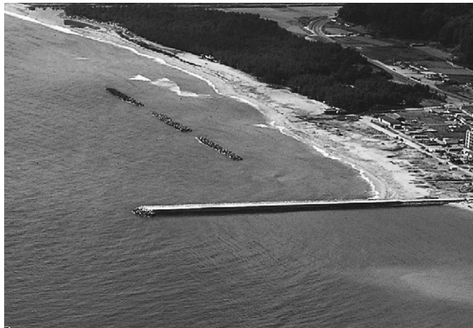
〈그림 4〉 연안정비사업을 통한 연안방재 사례 (방사제, 이안제)(경북 울진 구산)
